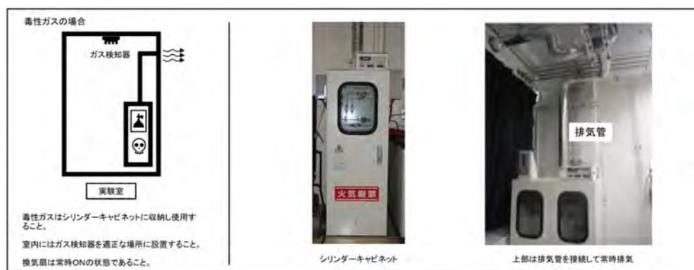
図 4.2 シリンダキャビネットの設置例
